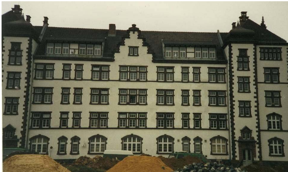
Das Dienstgebäude Ludwig-Mond-Straße 33, vom Hof aus gesehen
