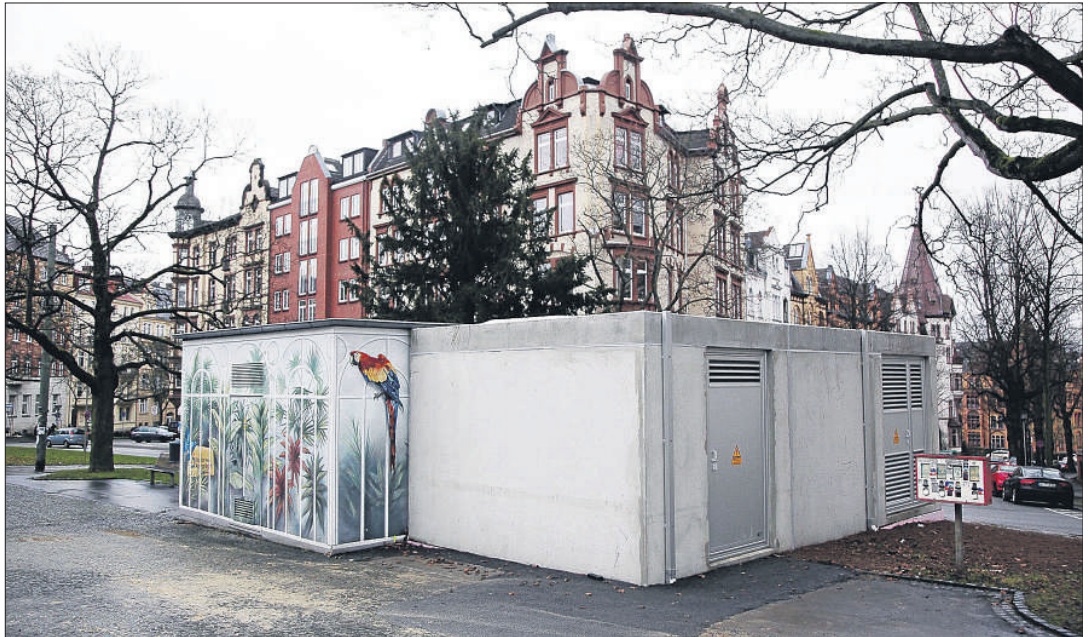
Unsensibel: Die KVG hat auf dem Bebelplatz ein Bauwerk zur Versorgung der Tram-Oberleitungen errichtet. Weder auf die Blickachse noch auf das daneben befindliche, von Friedel Deventer künstlerisch gestaltete Trafohäuschen wurde Rücksicht genommen. Foto: Koch
