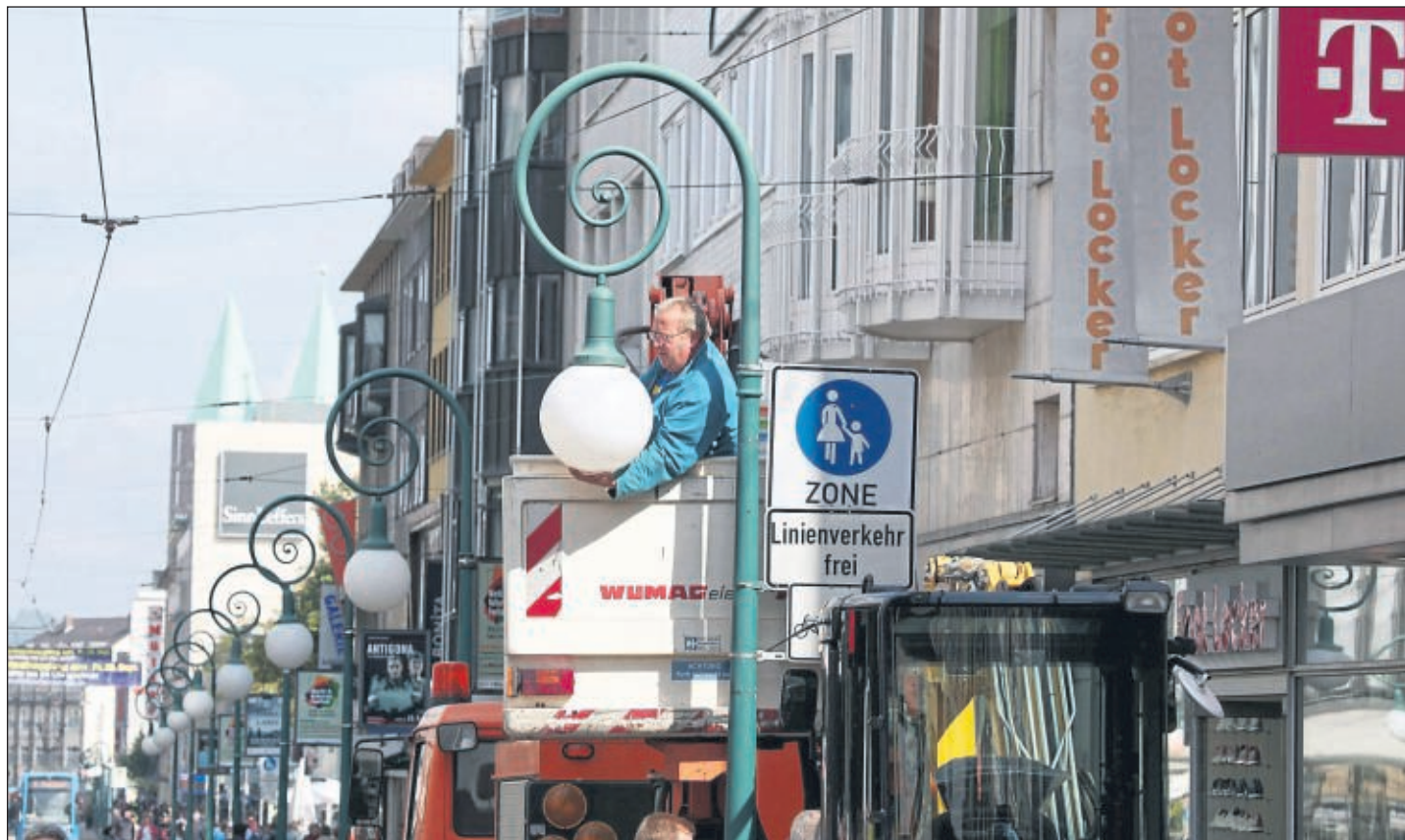
Nach Einschätzung des Oberbürgermeisters ein gutes Beispiel für Bürgerbeteiligung in Kassel: der Umbau der Königsstraße. Unser Foto zeigt Mitarbeiter der Städtischen Werke, die zur Vorbereitung die Lampen der Straßenbeleuchtung entfernen. Archivfoto: Koch
