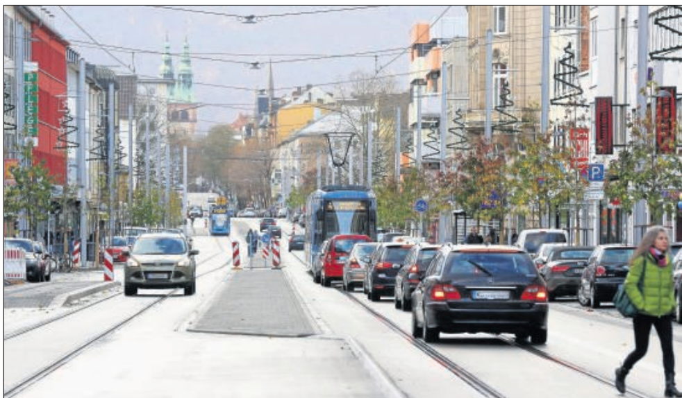
Transparenz und Akzeptanz: Sogar ein Stadtbüro für Anwohner und andere gab es an der Friedrich-Ebert-Straße für die gesamte Zeit der Bauarbeiten.
